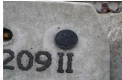
Bild 3.43 Frühentschaler. Spannstahlverschluss mit interner Kennung (Herstellung vom 22. Sept.)
