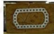
Bild 3.19 Sicherung mit Schwellenkronenplatte, gelöchert
