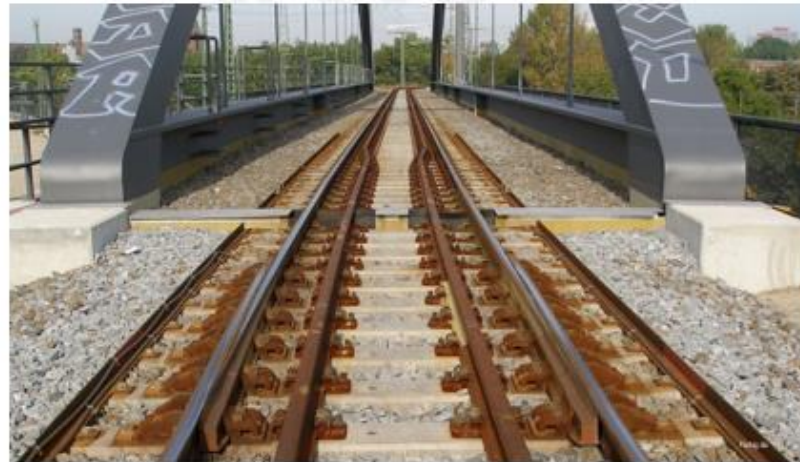
Bild 4.19 Schienenauszugsvorrichtung (Sav)
