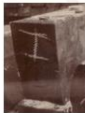
Bild 3.20 Kopfsicherung, Rotbuche mit Holzschraubdübel (Slowakei)
