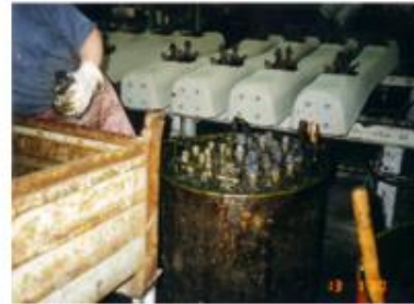
Bild 3.41 Späterschalung. Betonschwellen mit Schienenbefestigung belegen
