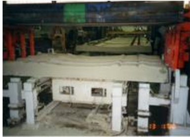
Bild 3.40 Späterschalung. Arbeitsschritt 7: Abgelegte, entschalte Betonschwellen
