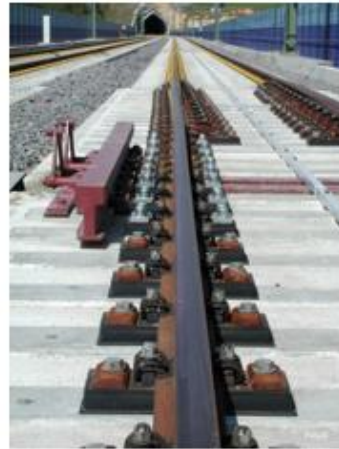
Bild 4.18 Schienenauszug (Schienenauszugsvorrichtung mit Dämpfungselement)
