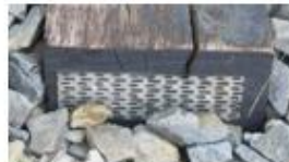
Bild 3.18 Sicherung mit Nagelplatten
