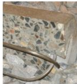
Bild 3.45 Haarnadelverankerung vom Schwellenende der B.70 (nachträglicher Verbund)
